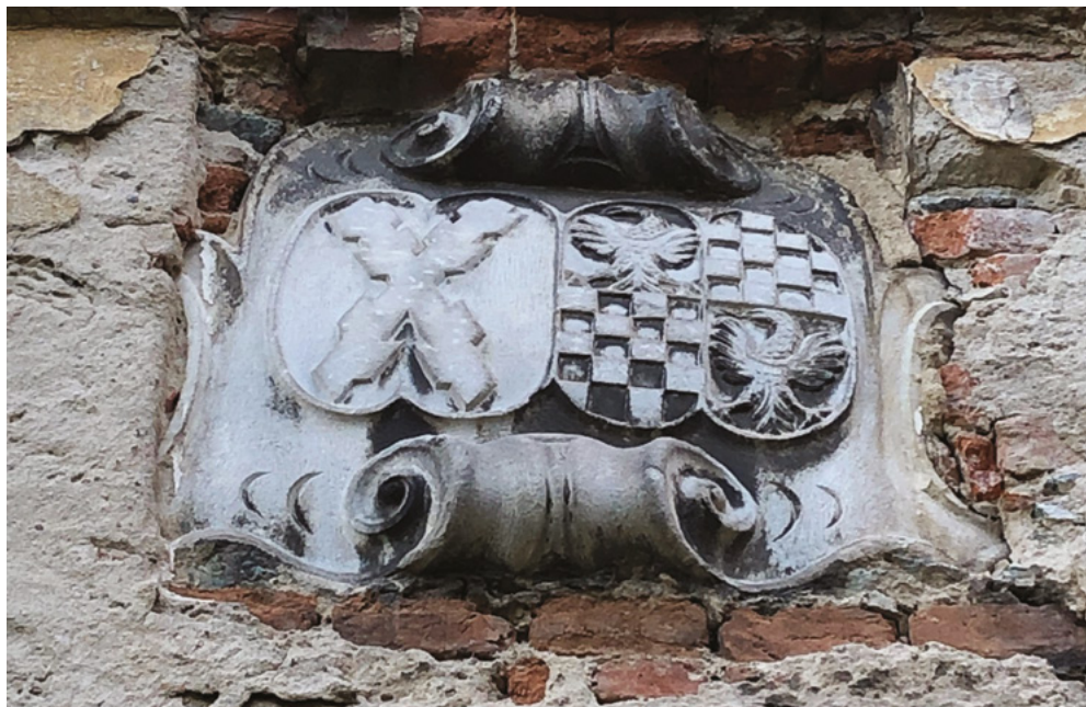
Obr. 3: Sventníky, alianční znak pánů z Lipé a lehnicko–břežských vévodů (detail), současný stav © foto Kamila Návrátová 2022
