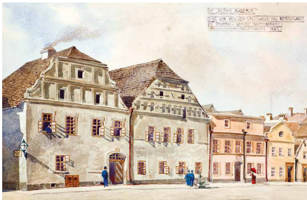
Obr. 16: Opava, malá kasárna na místě někdejší hlavní pošty na Masarykově ulici, Moritz Hartel, kol. 1900 © Slezské zemské muzeum, UHP, inv. č. U 627 A.
